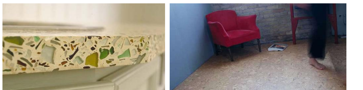
Figuras 46 e 47 – Fotografias de bancada de cozinha feita com desperdícios de vidro e cimento; e pavimento feito com o aproveitamento de desperdícios de madeira – eco-friendly flooring (Fonte: lcestone e www.ecofriendlyflooring.com )
