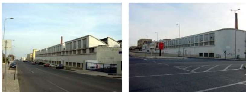
Figuras 104 e 105 – Fotografia do exterior do edifício existente, Av. De Pádua e Av. Infante D. Henrique (Fonte: Plano de Pormenor Projecto Urbano Parque Oriente, volume 2)
