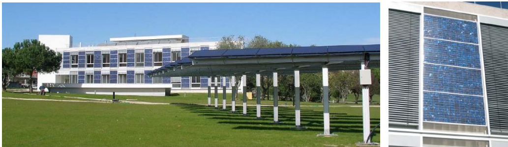
Figuras 121 e 122 – Fotografias do edifício Solar XXI e respectivo parque de estacionamento integrando painéis fotovoltaicos (Fonte: INETI, 2005)
